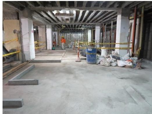
Los trabajos que iniciaron en el mes de enero, se centraron durante el primer trimestre del año en la demolición de muros y mesones. Actualmente se adelanta la etapa de construcción de la nueva cimentación de la estructura principal. Según el cronograma esta obra estará lista en el mes de diciembre de 2.020.
